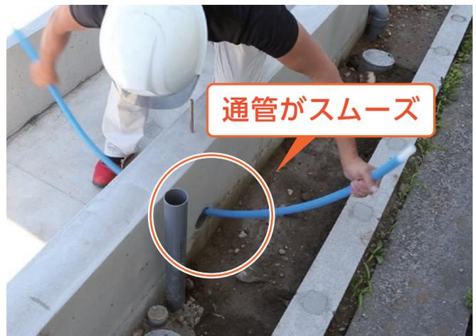
コルゲート管はすべり性があり、外径もスリムなので、スリーブへの通管がスムーズに行えます。
