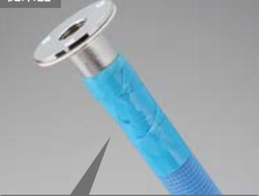
被覆材の縮みによる樹脂管の露出を防止するため補修テープを使用
