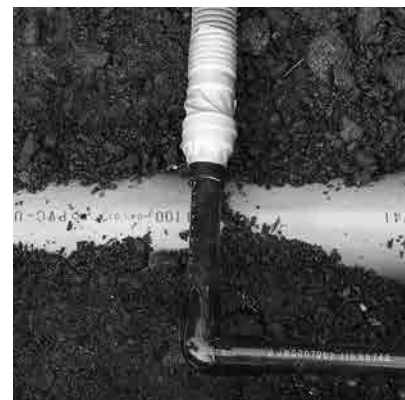
HIVE変換アダプター施工例 P109
