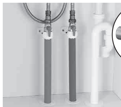
■流量調整ボールバルブ施工例 (WB27型)
