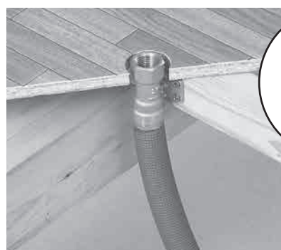
■床下横取付アダプター施工例 (WJ30型)
