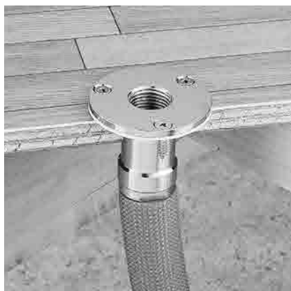
■配管アダプター施工例
