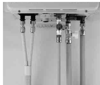
給湯器配管施工例 (CBW7型)
