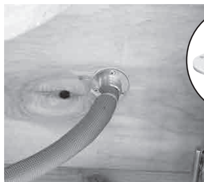
■床下取付アダプター施工例 (WJ23、43型)
