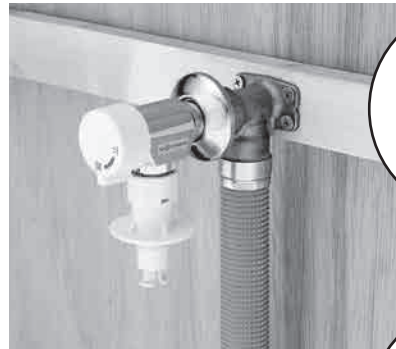
■座付水栓エルボ施工例 (WL5型) P100
