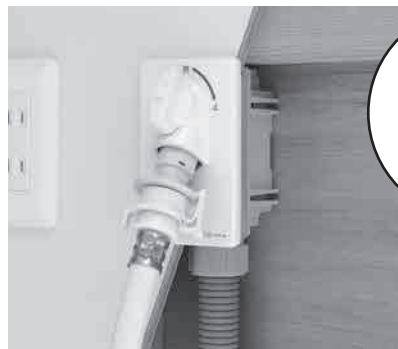
■洗濯機用コンセント施工例 (WF1型) P87
