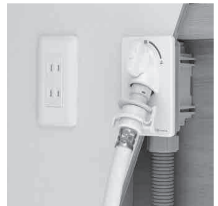
■洗濯機用コンセント施工例
