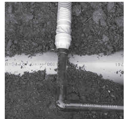
■HVP変換アダプター施工例 P109
