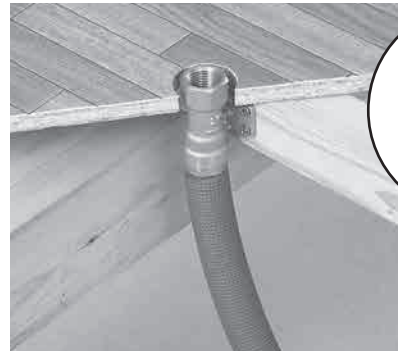
■床下横取付アダプター施工例 (WJ30型)
