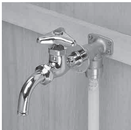
■座付水栓エルボ施工例
