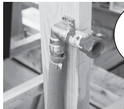
■右座水栓エルボ施工例 (WL36型) P85
