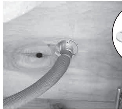
■床下取付アダプター施工例 (WJ23、43型)
