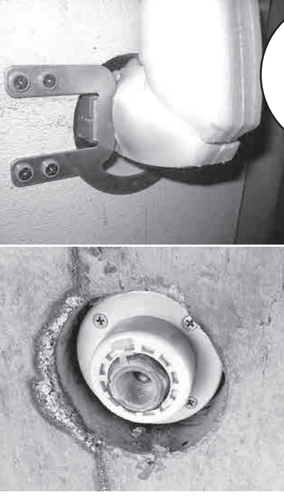
■たて型水栓ジョイント施工例 (上：屋内側、下：屋外側) P59
