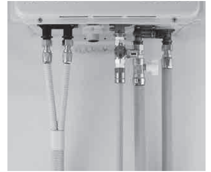
■給湯器配管施工例 (CBW7型)
