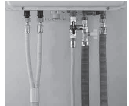
給湯器配管施工例 (CBW7型)
