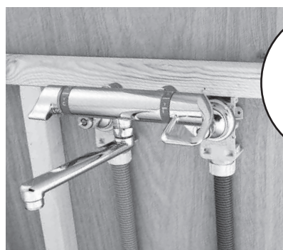
■水栓ボックス施工例 (WG2型) P45
