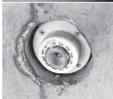
■たて型水栓ジョイント施工例 (上：屋内側、下：屋外側)
