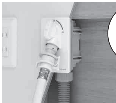
■洗濯機用コンセント施工例 (WF1型) P57
