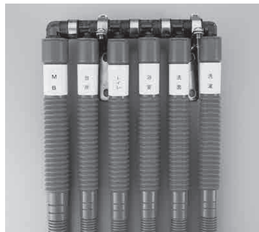
■給水ヘッダー施工例 P31, P60
