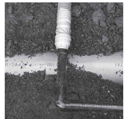
HWP変換アダプター施工例 P109
