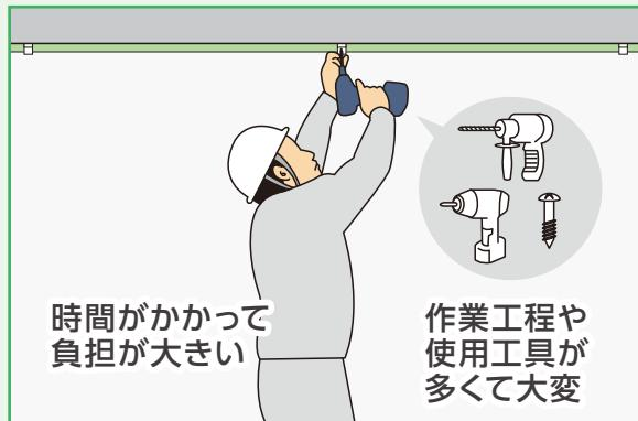
穴開け→コンクリートピン打設→ビス止めが必要で、
