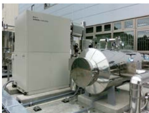
ヒートポンプチラーとタンク
