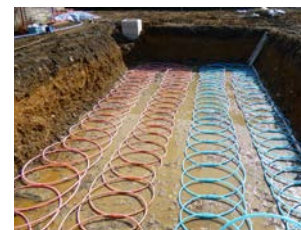
水平埋設状況
